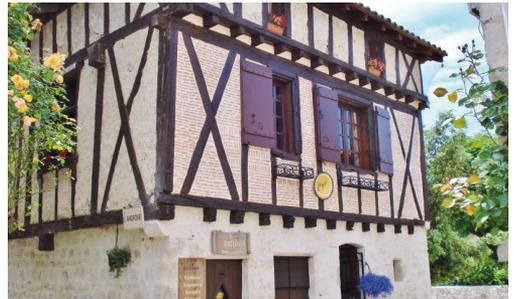
La structure à pan-de-bois permet une mise en œuvre rapide de la construction qui utilise des matériaux locaux. La maison se compose d'un rez-de-chaussée en pierre, sur lequel sont bâtis un étage et des combles à pan-de-bois. Le hourdis, remplissage du mur entre les poutres, est fait de torchis ou de brique. Chaque niveau correspond à une fonction : le rez-de-chaussée est occupé par l'atelier ou la boutique, l'étage sert d'habitation et le grenier, de lieu de stockage.
